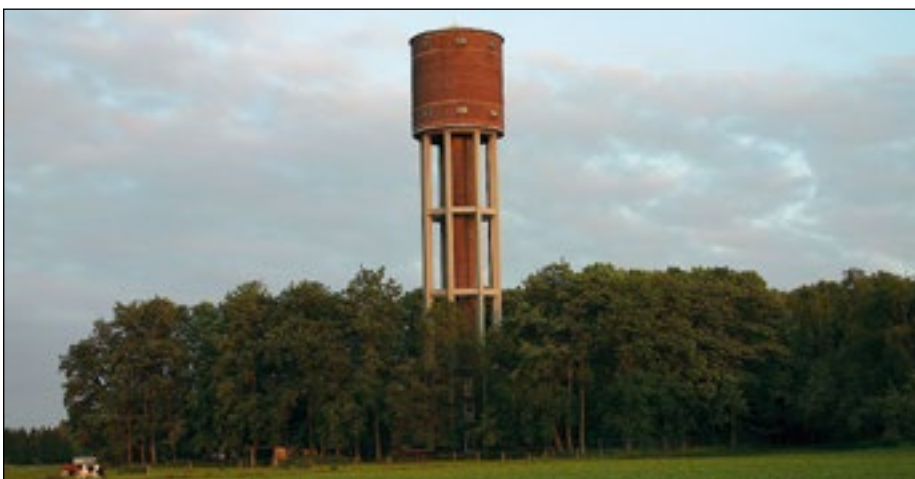
In Wegberg werden über 70.000 Euro für Instandsetzungsarbeiten am Wasserturm Uevokoven verwendet.
