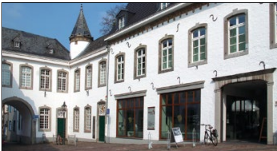
In Heinsberg fließen die Mittel in Instandsetzungsmaßnahmen am Heimatmuseum.
